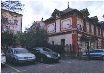
Aile à réaménager
